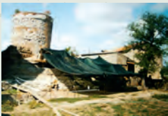
Cantiere al Sepolcro di Priscilla, 2002.
